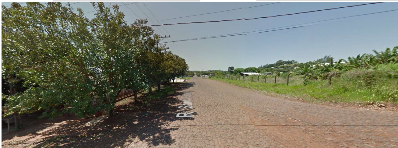
Começo da pavimentação. Estaca OPP. Esquina com Rua Otavio Francisco de Mattos
